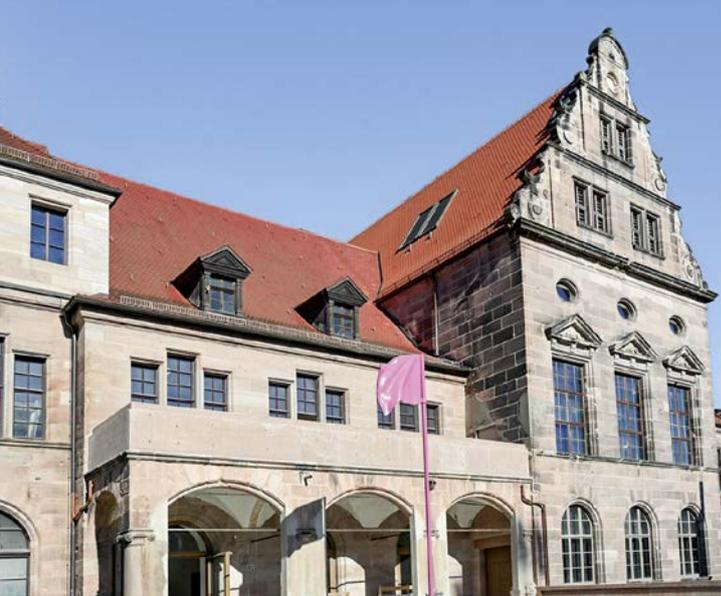
**7.160 Quadratmeter** wurden mit dem dritten und letzten Bauabschnitt grundlegend saniert sowie barrierefrei und technisch auf neuestem Stand nutzbar gemacht. Dazu gehören ein Lastenaufzug, ein ebener Übergang zum Biergarten und Brandschutz.
