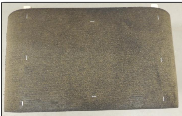
Abbildung 13 – Befestigung der Dachpappe mit Tackerklammern
