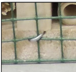
Abbildung 11 – Befestigung mit Hilfe von Kramen
